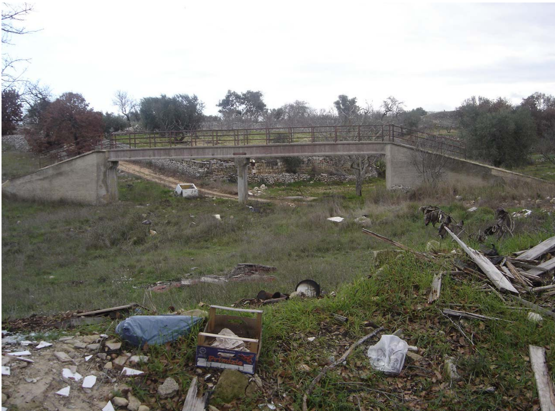
Fig. 1: Vista dello stato di degrado e abbandono in cui riversa la Lama San Giorgio in alcuni tratti
